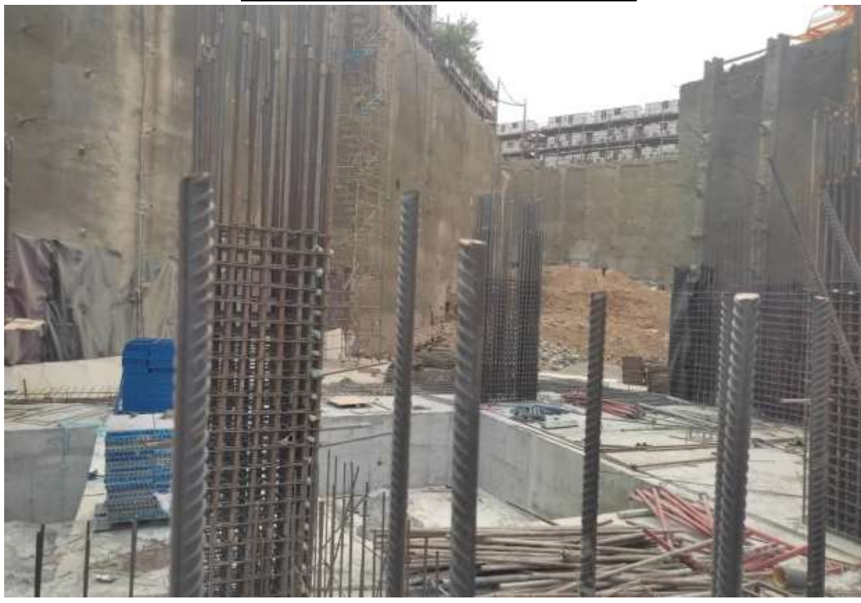
اتمام بتن ریزی فونداسیون پارت شمالی - مرداد ۱۴۰۰
